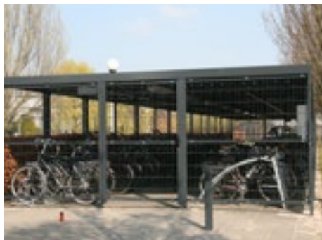
FalcoLok-500 klädd med svetsat stål nät, hela konstruktionen
