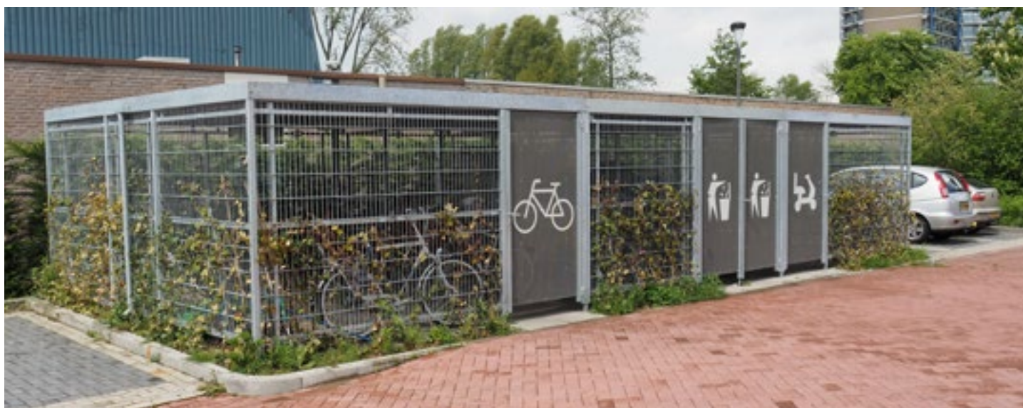
Ram klädd i svetsat stål nät, dörrar i perforerat stål med deskriptiva loggor
