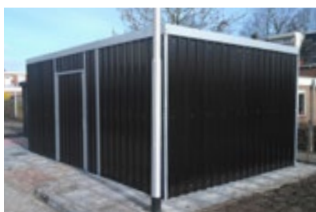
Ram klädd i korrugerat stål
