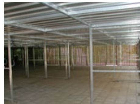
Takplåtar tillverkade av korrugerad aluzink
